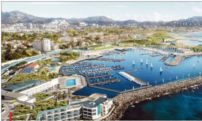
"On n'a pas de retard", affirme Cédric Dufoix concernant les travaux de la marina du Roucas Blanc, qui devrait être livrée entièrement début 2024.
