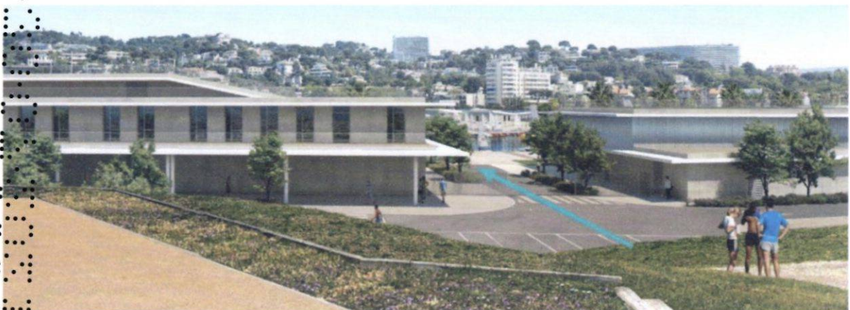
Percée visuelle entre les bâtiments 1 et 2
