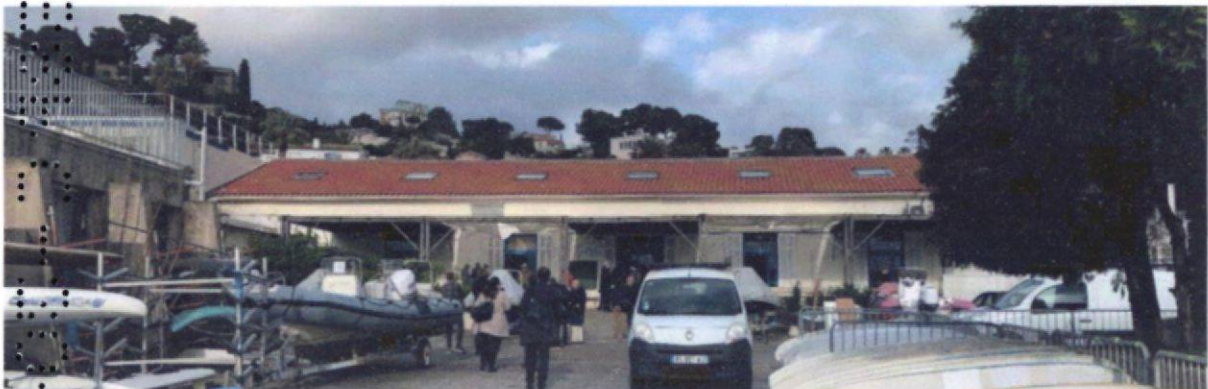
Photographie – Etat existant
