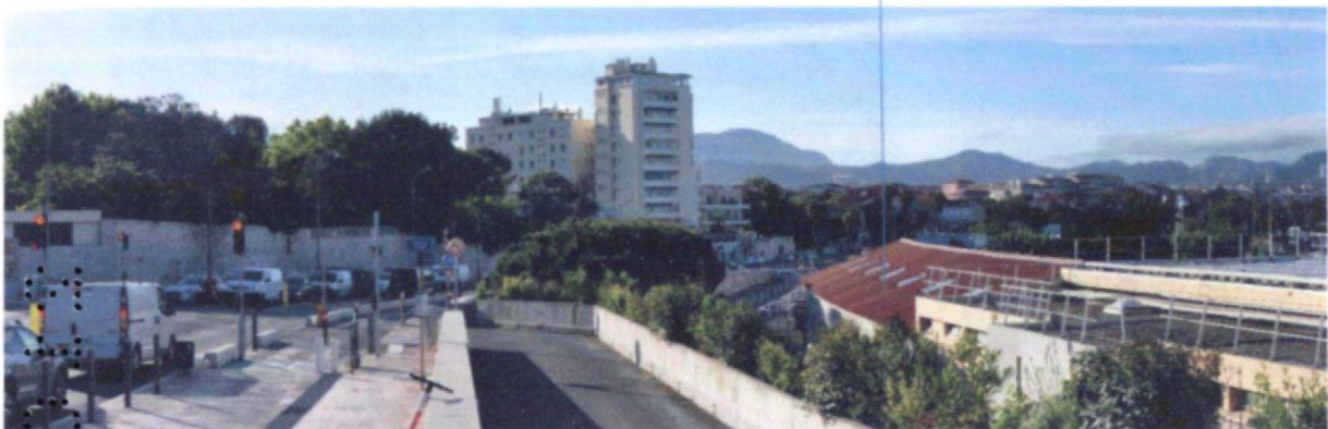
Photographie – Etat existant
