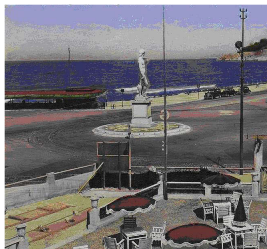
Statue mise en place le 17 novembre 1951.
