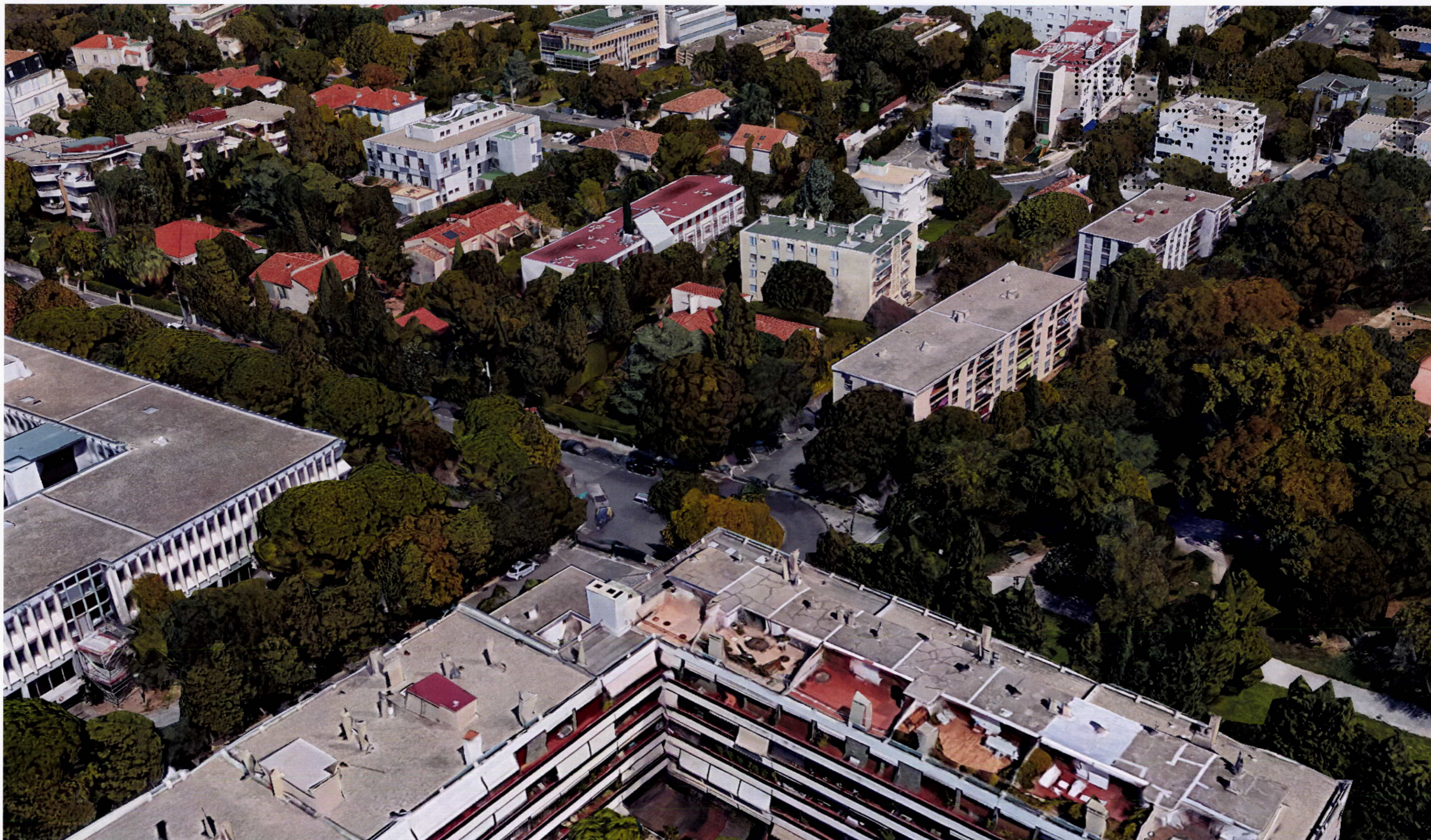
VUE AERIENNE DEPUIS LE SUD - ETAT EXISTANT
